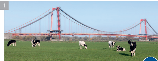
Rheinbrücke Emmerich (Baujahr 1963)
