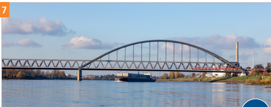
Hammer Eisenbahnbrücke (Baujahr 1987)
