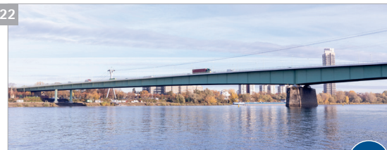
Zoo Brücke (Baujahr 1966)
