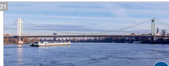
Mülheimer Brücke (Baujahr 1951)
