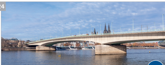
Deutzer Brücke (Baujahr 1948)
