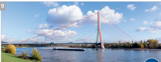
Fleher Brücke (Baujahr 1979)
