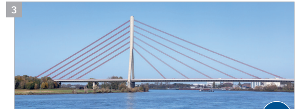
Niederrheinbrücke Wesel (Baujahr 2009)
