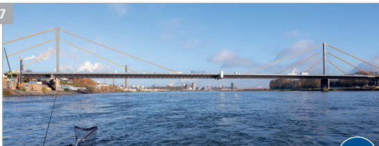
Rheinbrücke Neuenkamp (Baujahr 1970)
