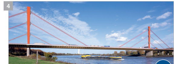
Beeckerwerther Brücke (Baujahr 1990)
