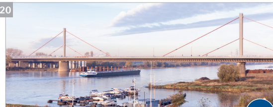
Rheinbrücke Leverkusen (Baujahr 1965)
