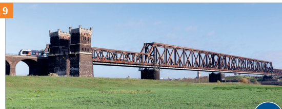
Duisburg-Hochfelder Eisenbahnbrücke (Baujahr 1949)
