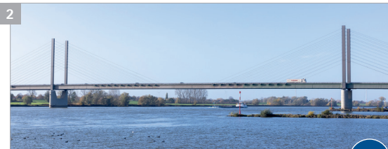
Rheinbrücke Rees-Kalkar (Baujahr 1967)
