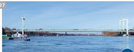
Rheinbrücke Köln-Rodenkirchen (Baujahr 1941)
